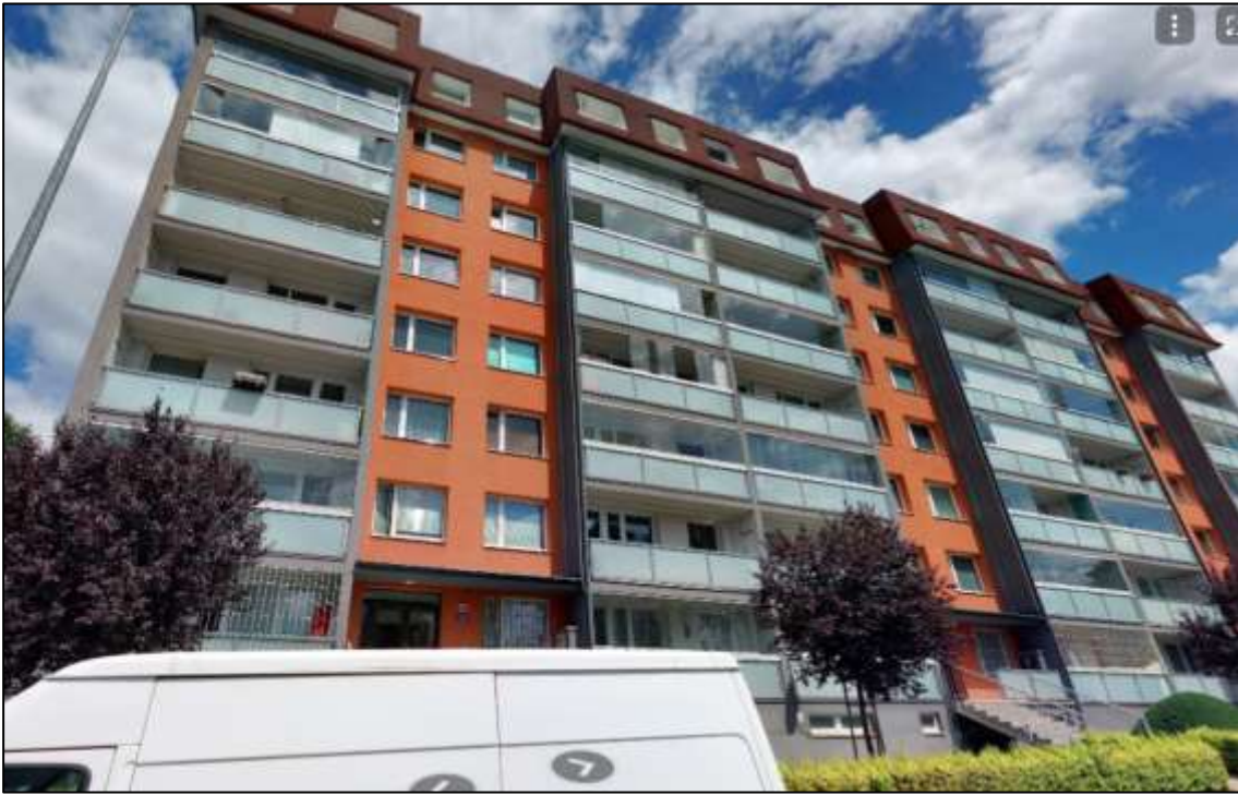
Celkový pohled na bytový dům.
